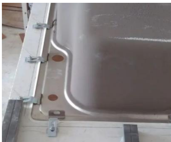
图例（AB 胶+专用卡托固定台下盆）
