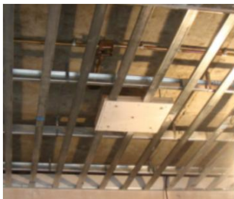
轻型吊灯基础处理示例
